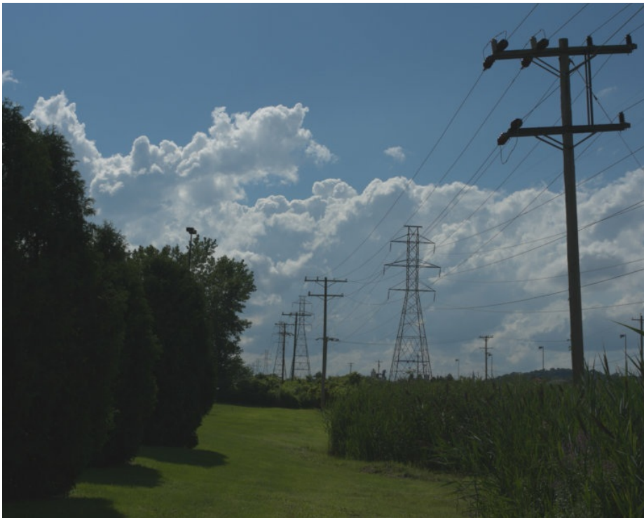
3. Τελική εικόνα "Ηλεκτρικά καλώδια"
