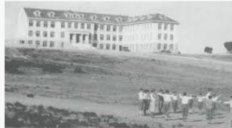
Το Μπενάκειο Διδασκτήριο λίγο μετά την έναρξη λειτουργίας του (1929)
